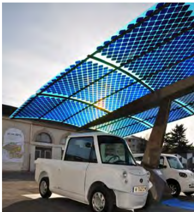
« ombrières » photovoltaïques sur un parking
