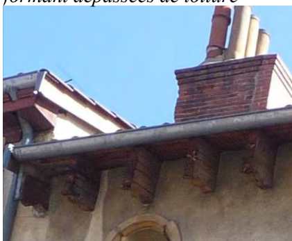
dépassée de toiture à chevrons débordant sculptés
