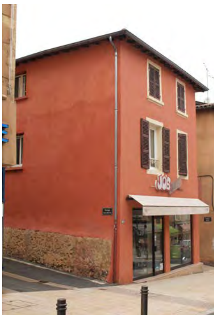
enduit traditionnel à la chaux rue Nationale
