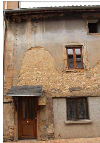
exemple de façade déstructurée
