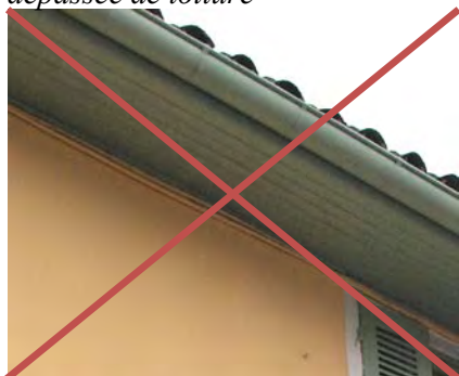
les dépassées de toitures lambrisées sont prosrites...
